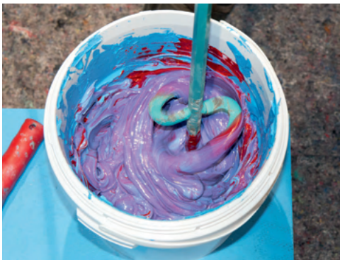
Mischen der Flüssigfolie bis homogene Farbe entsteht
