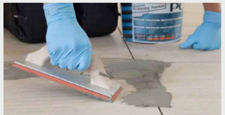
3 Verfugen mit PCI Nanofug ® Premium, Dehnfugen mit PCI Silcoferm ® S (o. Abb.)
