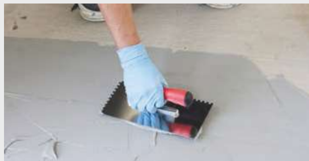
2 Dichtschlämme PCI Seccoral ® 2K Rapid aufspachteln
