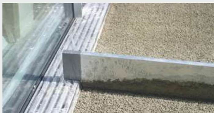
1 Drainagemörtel PCI Pavifix ® DM einbringen
