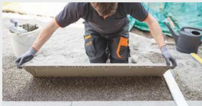
3 Einlegen der Platte frisch in frisch in den Drainagemörtel
