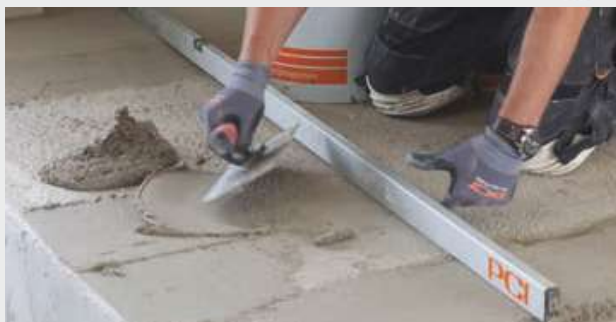
1 Gefälle mit PCI Pericret ® herstellen (mind. 2%)
