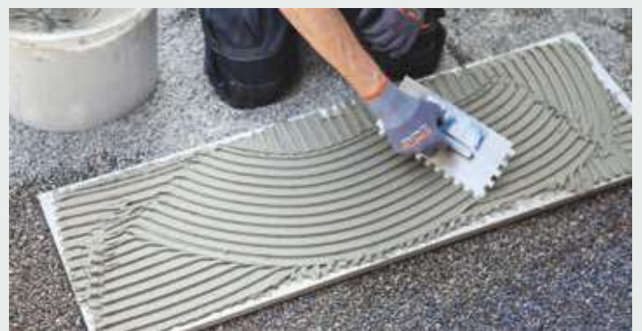
2 PCI Flexmörtel ® Premium rückseitig aufziehen
