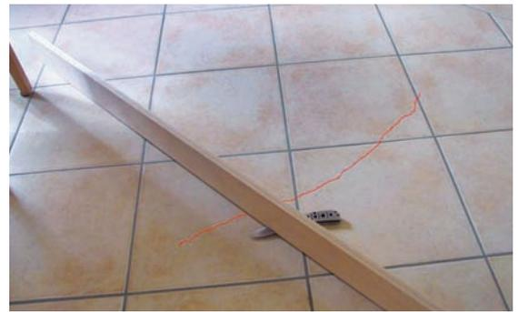
Abb. 5 – Riss im Keramikbelag (siehe rote Linie), verursacht durch Aufwölben und einhergehenden Bruch des Zementestrichs
