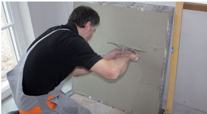
Abb. 11 – Das rückseitige Abspachteln verhindert Lufteinschlüsse und optimiert die Verbundhaftung.
