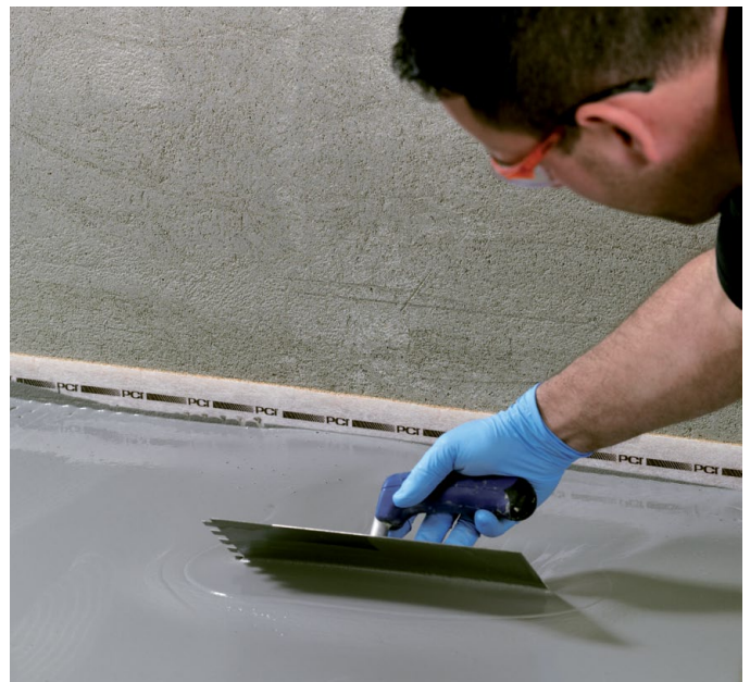
Abb. 4 – Mit der leicht verlaufenden Ausgleichsmasse PCI Periplan® fein können unebene Böden einfach und schnell egalisiert werden.
