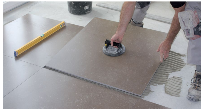
Abb. 12 – Verlegung einer Feinsteinzeugfliese im Format 90 x 90 cm, Hilfsmittel wie der hier verwendete Saugheber sind eine große Arbeitserleichterung.
