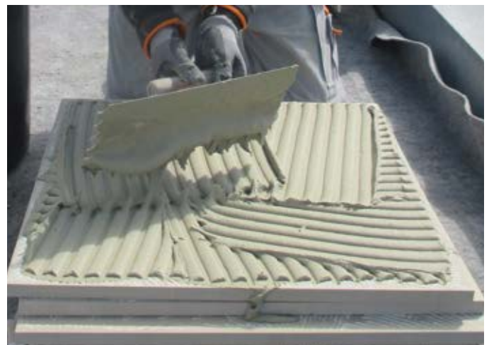
Abb. 15 – Aufziehen eines Drainestrichs auf eine mit PCI Seccoral® 2K Rapid abgedichtete Betonkragplatte.
