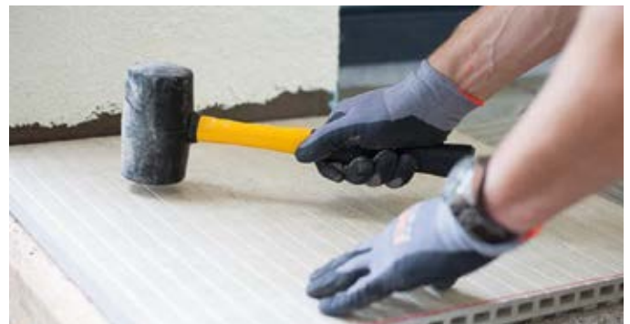
Abb. 16-17 – Aufziehen eines Mittelbettmörtels auf der Plattenrückseite vor dem Einlegen in den abgebundenen Drainmörtel.
