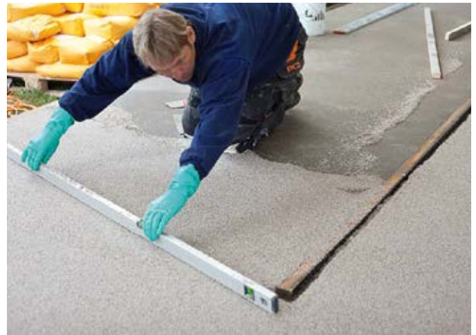
Abb. 15 – Aufziehen eines Drainestrichs auf eine mit PCI Seccoral® 2K Rapid abgedichtete Betonkragplatte.
