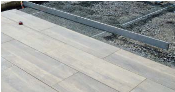
Abb. 13 – Einbringen eines Drainmörtels, gemischt aus Basaltspalt 2/5 und dem Bindemittel PCI Novoment® Z3 im Verhältnis 1:5.
