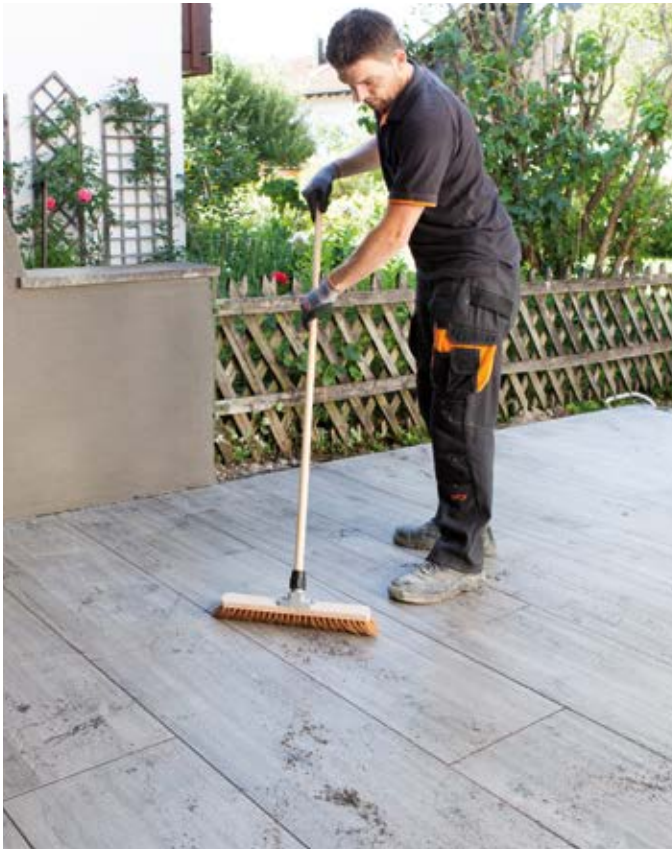
Abb. 22+23 – Einbringen der drainfähigen Fuge PCI Pavifix® 1K Extra – das Material wird verdichtend eingeschoben, sauber abgekehrt und die Fläche ggf. mit Wasser oder einem feuchten Besen nachgereinigt.
