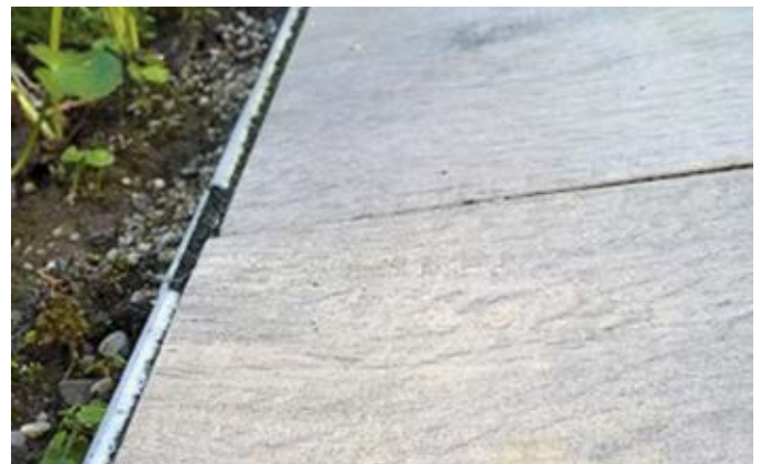
Abb. 9 – Nachteil lose Verlegung: Absackung einer lose gebetteten Platte trotz abstützendem Kies-Fanggitter.
