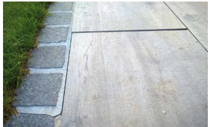
Abb. 9 – Nachteil lose Verlegung: Absackung einer lose gebetteten Platte trotz abstützendem Kies-Fanggitter.
