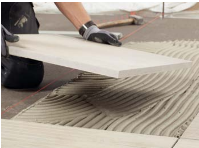
Abb. 18 – Bei der Verlegung im Verbund ist auf die nahezu hohlraumfreie Verlegung durch Buttering-Floating-Verfahren zu achten.
