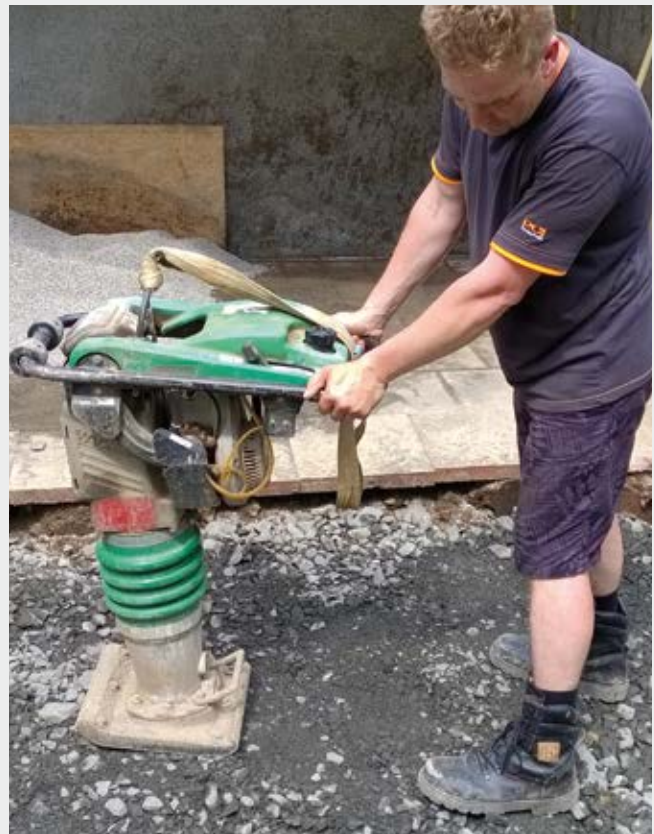
Abb. 5 – Einbau einer Frostschutztragschicht, ausreichend maschinell verdichtet.
