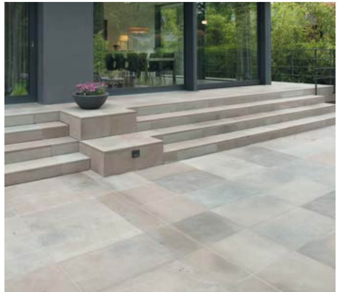
Abb. 24 – Auch mit Naturwerksteinplatten lassen sich analog der Keramik anspruchsvolle Flächen in der gebundenen Bauweise realisieren.
