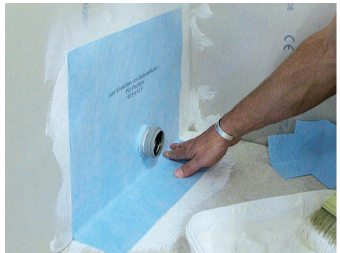
Abb. 4 – Verbundabdichtung PCI Lastogum®, Farbe weiß, aufgetragen. Gezeigt wird die Verklebung der Dichtmanschette 42,5 x 42,5. Alternativ ist es auch möglich, aus PCI Pecilastic® W eine Manschette herzustellen. Durch den Abstand zwischen Boden und Abflussrohr ist die Abdichtung funktionssicher herzustellen.
