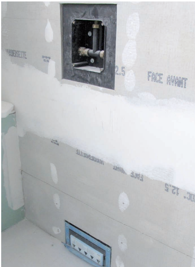
Abb. 17 – Wandeinlauf. Wandeinlauf mit Estrichhöhenbezugspunkt bzw. waagrechttem Klebeflansch.
