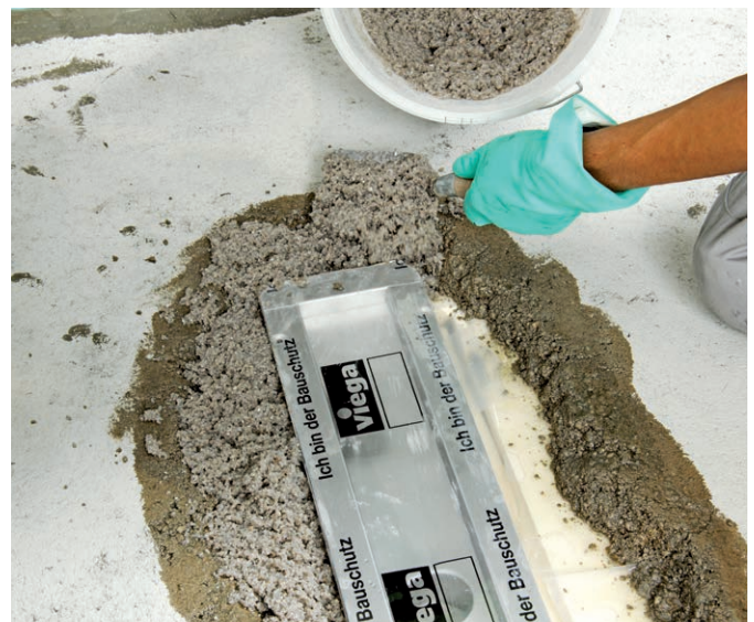
Abb. 12 – Schritt 2 – Verfllen der Estrichaussparung und Unterstopfen der Rinne mit Reaktionsharzmischung aus einem Teil PCI Bauharz oder PCI Epoxigrund 390 und vier Teilen PCI Quarzsand Nr. II. Der Einbau erfolgt auf frisch grundiertem Untergrund.
