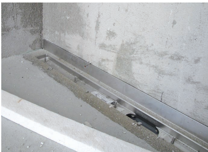
Abb. 18 – Duschrinne als Boden-Wand-Kombination Rinne, platziert am Übergang von Boden zu Wand sowie zur Raumecke.
