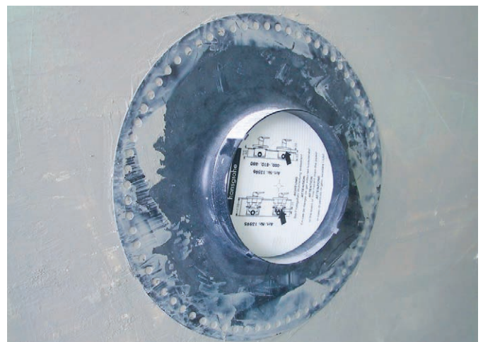
Abb. 6 – EPDM-Manschette, die Verbindung mit der Verbundabdichtung PCI Lastogum® erfolgt nur über die Löcher in der Manschette, geeignet für den privaten Bereich.
