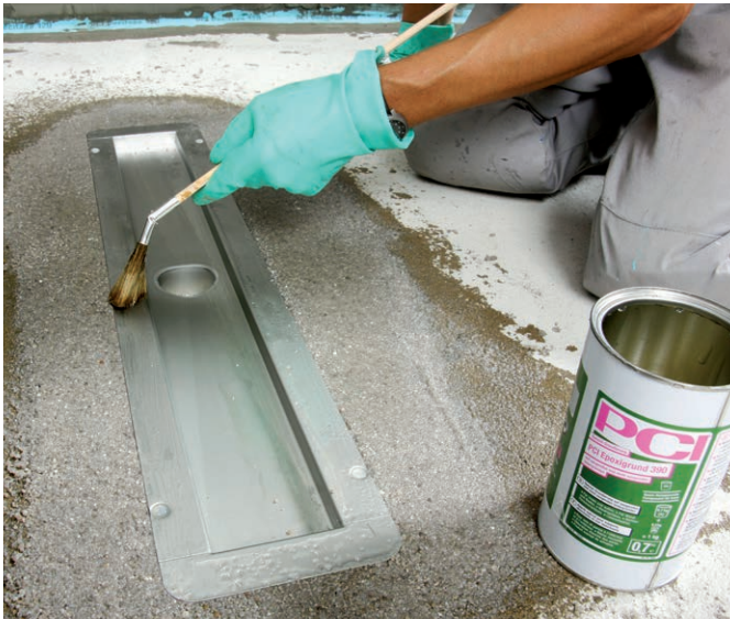
Abb. 13 – Schritt 3 – Nach dem Auffüllen der Aussparung ist die Bauschutzfolie der Rinne zu entfernen und die Metalloberfläche mit PCI Univerdünner zu reinigen. Die Rinnen-Klebeflanschfläche ist anschließend mit PCI Epoxigrund 390 oder PCI Bauharz zu grundieren.
