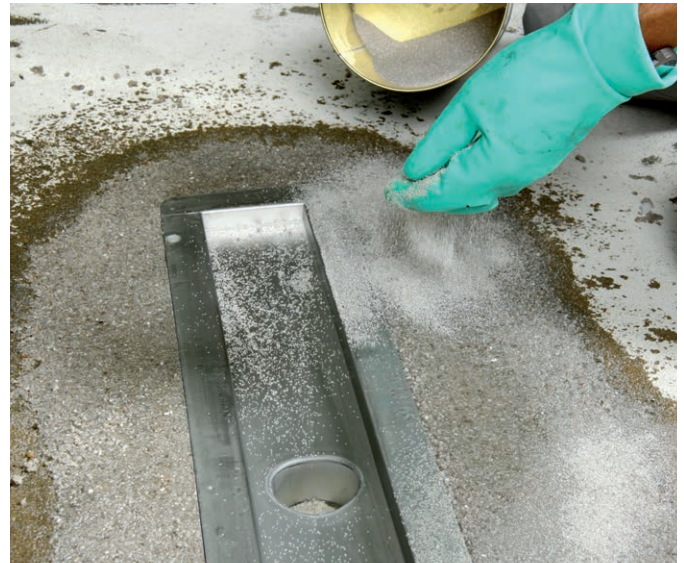
Abb. 14 – Schritt 4 – Die aufgetragene Grundierung und der Epoxidharzmörtel werden im frischen Zustand mit Quarzsand der Körnung 0,3 bis 0,8 mm abgestreut.
