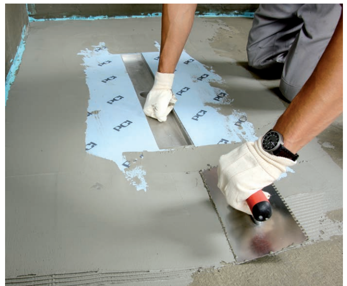
Abb. 16 – Schritt 6 – Einbau des Dichtbandes PCI Pecitape® 250 oder der Abdichtungsbahn PCI Pecilastic® W (Manschette gefertigt aus Bahnenabdichtung) im Übergang von Estrich zu Klebeflansch der Rinne.
