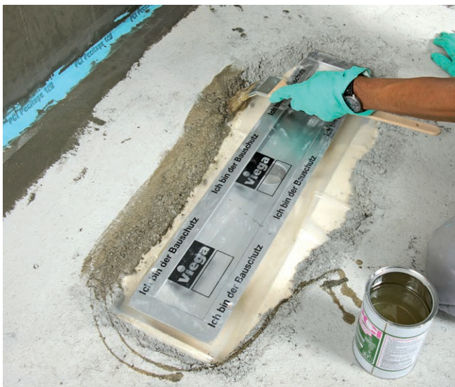
Abb. 11 – Schritt 1 – Grundieren der angrenzenden Estrichkanten mit PCI Bauharz oder PCI Epoxigrund 390. Auf eine satte filmbildende Benetzung ist zu achten.
